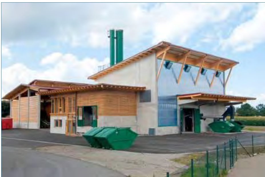
Abb. 16: Das Heizwerk der Wärmeversorgung Grassau (KU) mit Fernwärme, neben dem Gelände des Biomassehofs.
