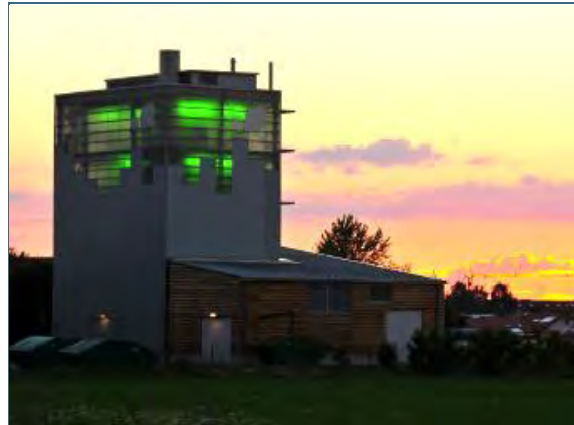
Abb. 18: Der Heatpipe-Reformer von agnion zur Vergasung von Holzhackschnitzeln.
